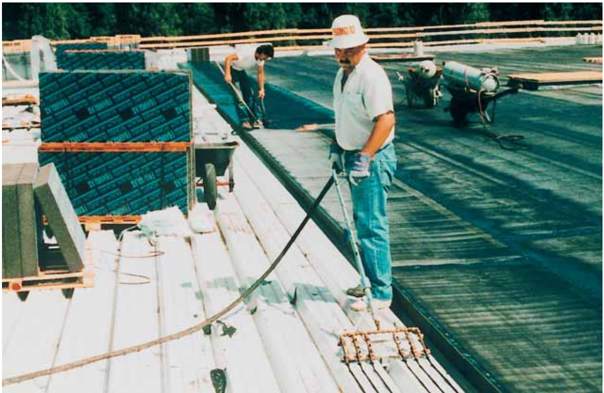
Auftragen des PC11-Klebers.
