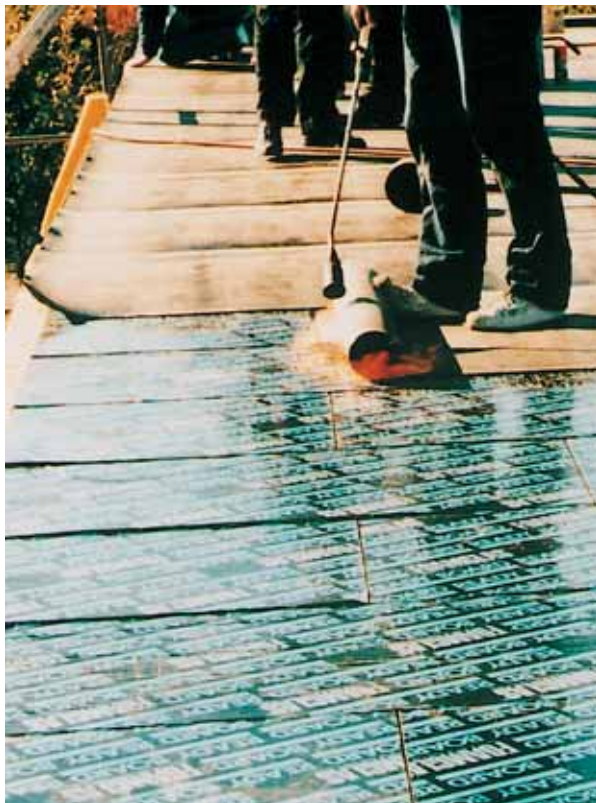
Aufflämmen einer Dachabdichtungsbahn auf FOAMGLAS® Ready Board
